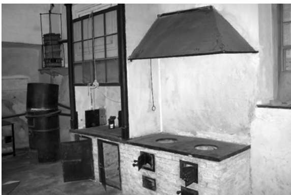
Abb. 8: Schloss Reichenau. Abzug mit Unterschranken und Herd mit zwei Feuerstellen. Höhe der Arbeitsflächen 77cm. Foto: Autor.
