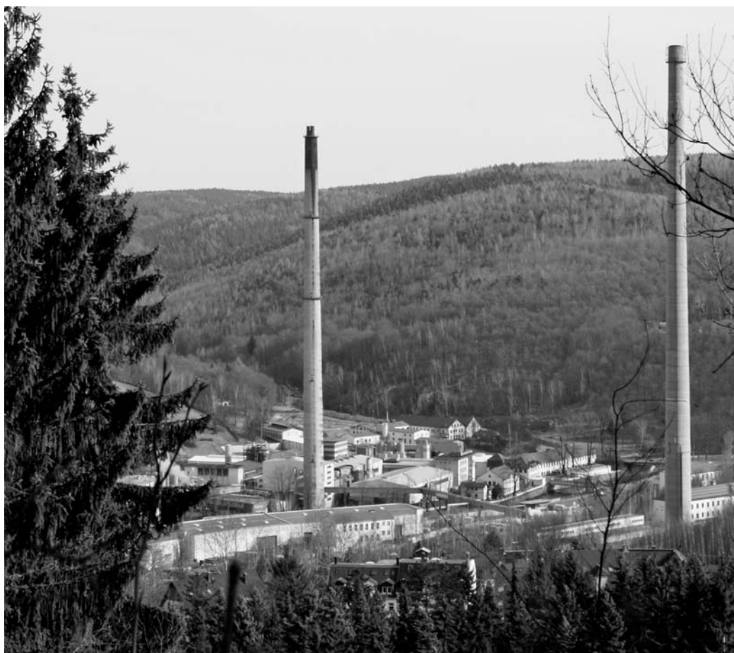
Abb. 5: Die Nickelhütte Aue aus ähnlicher Perspektive wie in Abb. 4. Das Bild wird von zwei 1974 bzw. 1984 errichteten Schornsteinen dominiert, mit denen die Umweltbelastung aus dem Tal in die Umgebung verlagert wurde. Heute werden alle Abgase des Hüttenbetriebes einer aufwändigen Rauchgasreinigung unterzogen. Die historischen Gebäude, in denen auch Clemens Winkler gearbeitet hat, sind auf dem Bild im hinteren Werksteil zu sehen. [Foto: Steiner]
