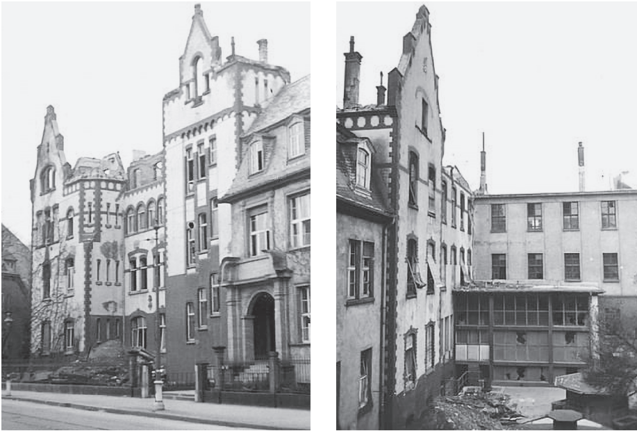
Abb. 20 Zerstörungen am IET durch Bombentreffer 1944
